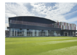
柴田町総合体育館
